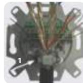
**4.** Asegure el cable al soporte (1) usando una brida.
